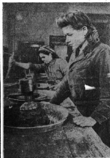
На переднем плане: работница т. Лукьянова шлифует линзы.
