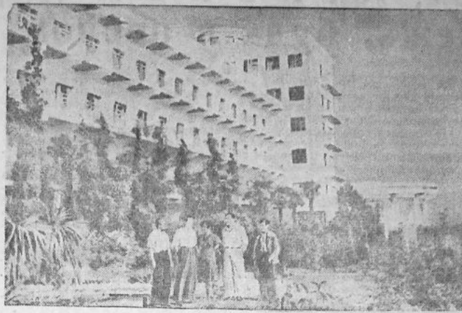
Сочи. Недавно отстроенное здание санатория "Нога Риверо". Прессклип с ТАСС.
