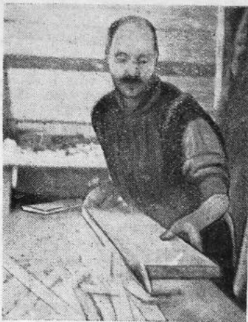
По-стахановски работает в Загорской строительной котлере плотник А. К. Грофимов, постоянно перевыполняя все задания. На снимке: тов. Грофимов за изготовлением драпки, необходимой для штукатуривания стен и потолков. Фото В. Варыканова.
