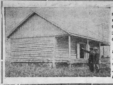
В колхозе селения Ретово закончено строительство зернохранилища, емкостью на 50 тонн. На снимке: бригады колхоза А. П. Крыжовников и А. А. Вралев осматривают постройку.
