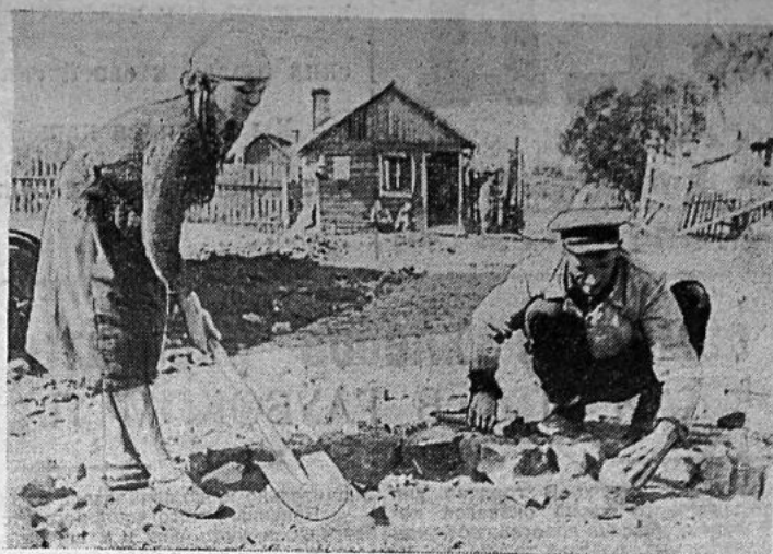
К 800-летию Москвы на Кирпичном заводе Министерства путей сообщения будет построена новая булыжная мостовая, благодаря чему благоустроится подвездной путь к заводу. На снимке: мостовщики М. Д. Ефимов и А. С. Ефимова — за работой. Фото В. Варыханова.
