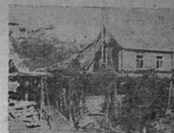
На строительстве колхозной гидроэлектростанции в с. Козрово. Строительство должно быть закончено к 30-й годовщине Октября.
