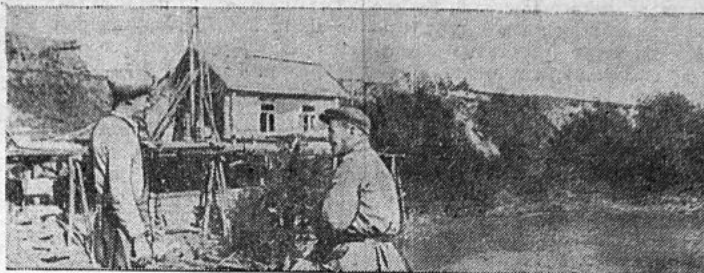
К 30-летию Октября в колхозе Коврово должно быть закончено строительство Ковровской колхозной гидроэлектростанции. На снимке: производитель работ (от Моссельэлектро) П. Н. Мефодьев (справа) беседует с землекопом-стахановцем П. Н. Петровым.
