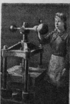
В Загорском шиноремонтном заводе кроме ремонта автомобилей производятся также прессовка вентиляторных ремней.
