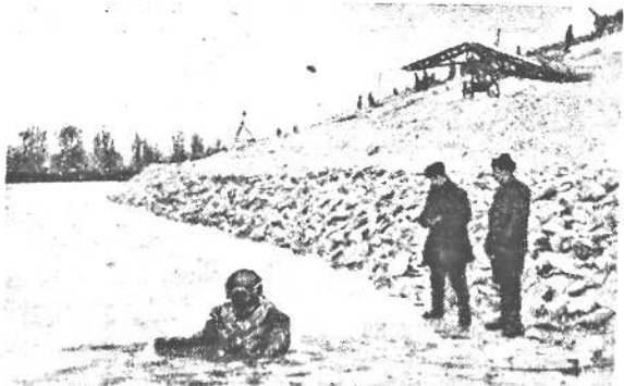
Великие стройки коммунизма. В Красноармейском строительном районе Волгодонской идет крепление наружной и подводной части откосов готовой части канала. Наружная часть облицовывается железобетонными плитами, а на подводную — накладывается фильтр из песка, щебенки и камня. На снимке: водолаз Б. Н. Васильев опускается под воду для контроля за укладкой подводного фильтра. Фотохроника ТАСС.
