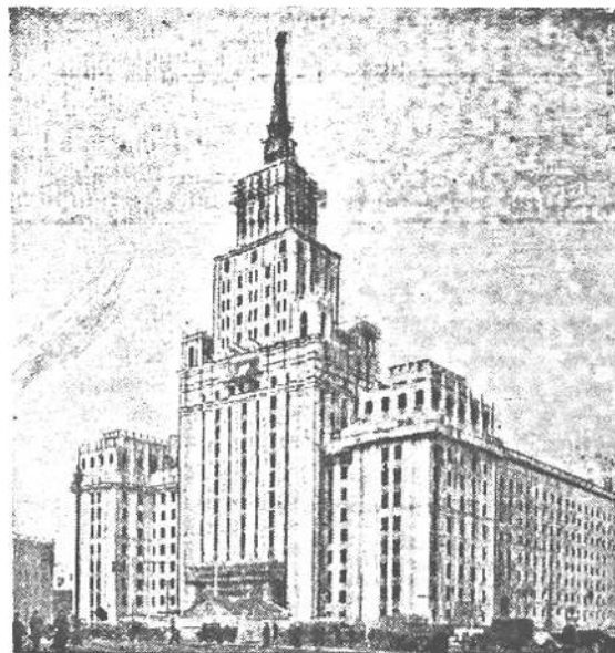
Строительство высотного здания Министерства путей сообщения у Красных ворот.
