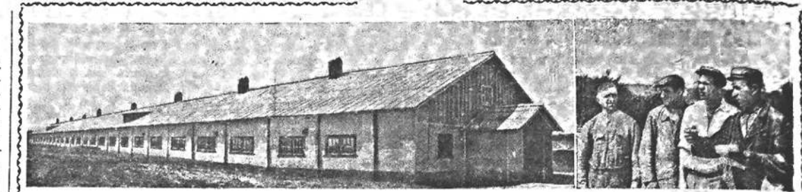
В колхозе имени Крупской скоро будет сдан в эксплуатацию скотный двор на 125 голов крупного рогатого скота. Он построен по новому типовому проекту: здесь механизирована подача воды, смонтирована подвесная дорога для доставки кормов, установлены автопоилки.
