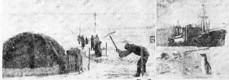
На снимке: слева — строительство поселка Мирный. Подготовка места для установки радиомачт. Сарва — флагманский корабль экспедиции «Обья» у берегов Антарктиды.
