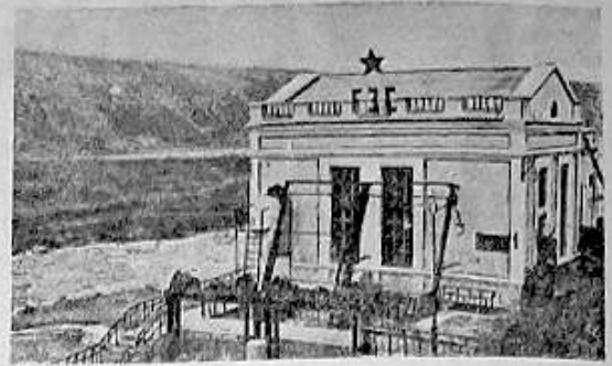
В Николаевской области на реке Южный Буг сооружена Константиновская межколхозная гидроэлектростанция мощностью 800 киловатт. В строительстве ГЭС принимают участие колхозы Арбузовского и Доманевского районов. Первые 14 колхозов уже получили электрический ток для освещения домов и для нужд колхозного производства.
