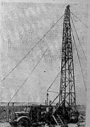
Казахская ССР. В новом термомокозле «Ждановский», созданном на целинных землях, Исыкские подпольные вод на территории совхоза с помощью передвижной буровой устанавли-
