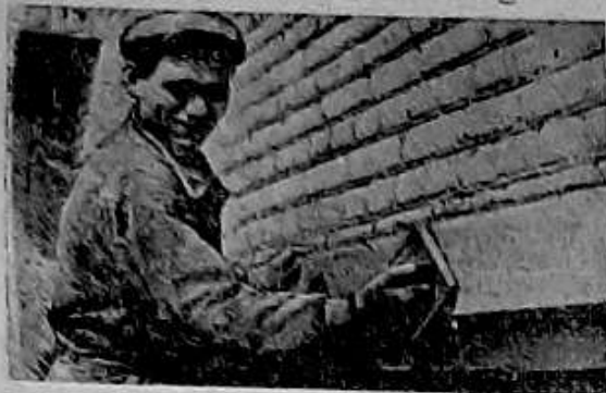
11 лет работает строителем К. Е. Горьков. Сейчас он бригадир штукатуров. В его бригаде, которая работает на строительстве домов Киевского поселка, 9 человек. До 200 процентов выполняет она производственный план.
