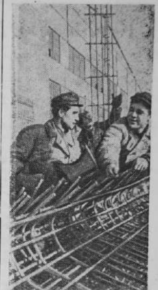
Днепропетровск. На заводе металлических конструкций имени Бабушкина началось строительство цеха по производству стальных труб методом автоматической электросварки.
