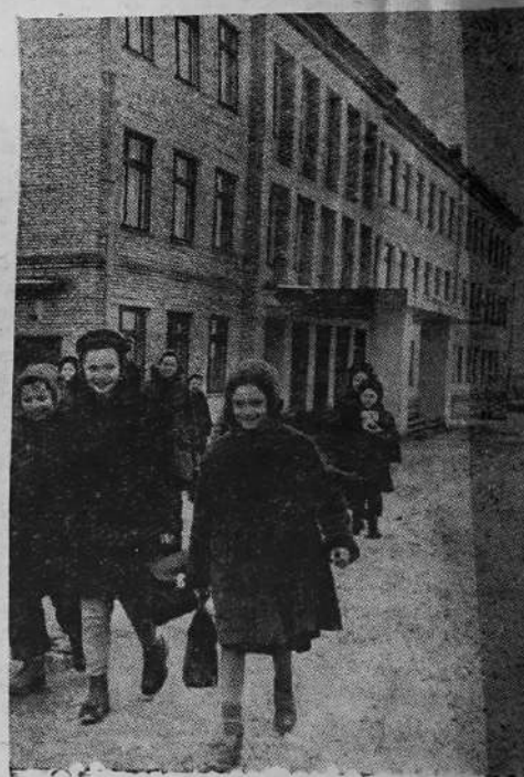
Новая школа на Северном поселке.
