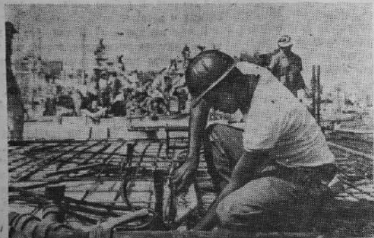
Кубинский народ с большим энтузиазмом отдает силы хозяйственному и культурному строительству. В стране сооружаются учебные центры, в городах создаются жилые районы. Большое строительство ведется в столице Кубинской Республики — Гаване. На снимке: участок строительства нового жилого района в пригороде Гаваны.
