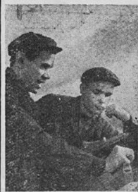
На Первоуральском новотрубном заводе сооружается крупный цех непрерывной прокатки стальных бесшовных труб. Он оснащается оборудованием, которое позволит прокатывать трубы на высокой скорости.
