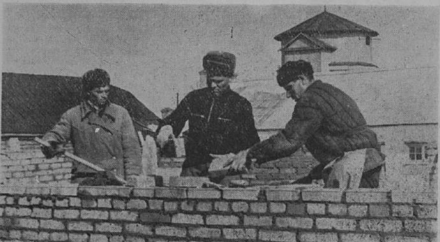
В Конкурентном совхозе строится доильный зал для молочнотоварной фермы. Совхозная строительная бригада (бригадир А. Саблин) в кратчайший срок — всего за три недели — провела кладку стен и внутренних перегородок. В новом
