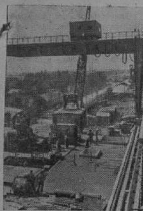
Таджикская ССР. Хороший подарок к 45-й годовщине Великого Октября подготовили таджикские энергостроители. Под промышленную нагрузку поставлен пятый турбоагрегат Душанбинской теплоэлектростанции мощностью 25 тысяч киловатт.
