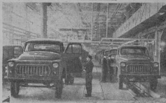
Горьковский автомобильный завод реконструируется. Выпуск грузовых и легковых автомобилей значительно увеличится. Замечательную трудовую победу одержали автозаводцы. В феврале вступил в строй новый главный конвейер сборки грузовых автомобилей «ГАЗ-53Ф». Он показан на снимке.
