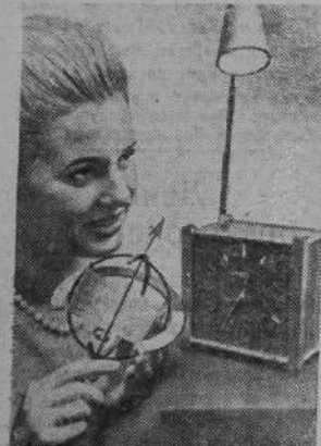
«Световые» часы (справа) изготовлены одной из фирм Швейцарии. Фотоэлемент, чувствительный даже к небольшой дозе света, вырабатывает энергию для маленького мотора. На снимке: слева — копия старинных солнечных часов.
