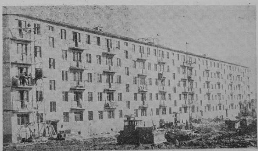
В микрорайоне «Углич» идет отделка 120-квартирного жилого дома. Это будет самый большой
