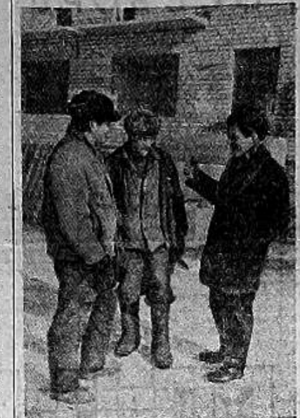
На Рабочем поселке Загорска строится жилой дом, предназначенный для молодых специалистов оптико-механического завода. Сейчас заканчивается кладка стен второго этажа. Активное участие в строительстве принимают будущие жильцы — молодые инженеры и техники ЗОМЗ.
