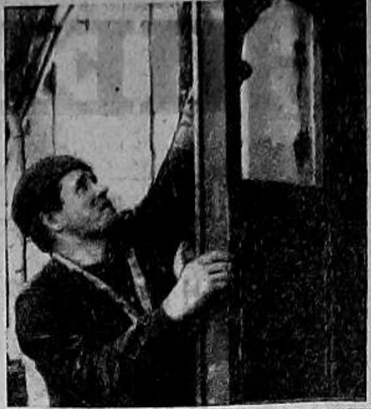
Пятый год работает в УКСе Загорского электромеханического завода плотник АЛЕКСЕЙ ШЕПЕЛ'НИКОВ. Один из лучших строителей управления, он освоил ряд смежных профессий. Наш корреспондент Н. Ириченко сфотографировал А. Шепел'никова в тот момент, когда он устанавливал стекло в новом жилом доме на Каменитовском поселке. Эту работу он выполнял, как всегда, качественно и быстро.
