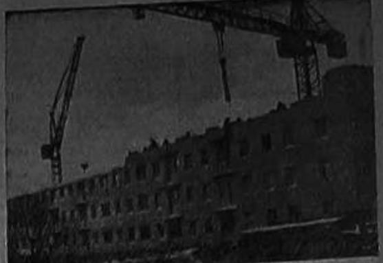
ЗАГОРСК СЕГОДНЯ. На Хотьковском шоссе города развернулось строительство 100-квартирного жилого дома для рабочих ЗЭМЗ. Фото П. Кризатов.
