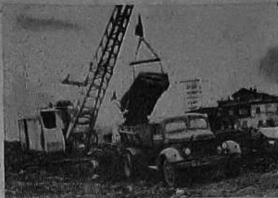
ЗАГОРСК СЕГОДНЯ. На месте будущей центральной площади города сейчас идут земляные работы, снесены последние старые дома.
