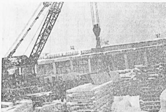
Хотьковский опытно-экспериментальный завод мостовых конструкций — предприятие высокой культуры производства, оснащенное современной техникой. За последние годы здесь механизированы многие трудоемкие операции.
