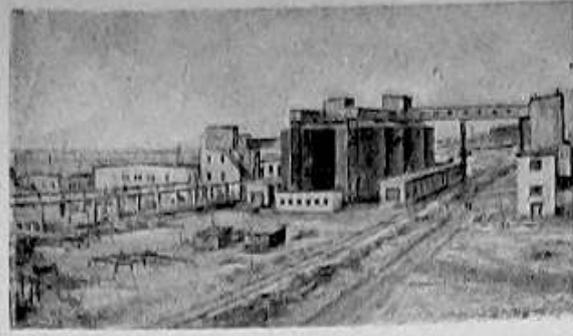
На окраине г. Можгова завершено строительство крупного завода железобетонных изделий для новостроек Западного Урала. Его цеха оснащены новейшим оборудованием — мощными бетононасосами, транспортерами, электромеханическими, пневматическими машинами. Механизация позволяет выпускать продукцию поточным методом. За год завод должен дать 16 тысяч кубических метров железобетонных изделий, из них пять тысяч кубометров — на полигонных площадках.
