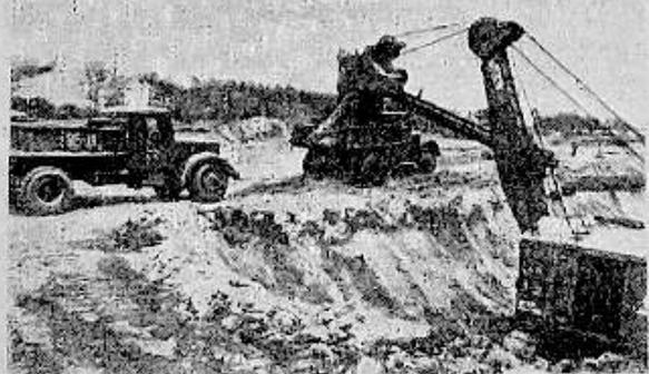
На строительстве Саратовской ГЭС одним из важнейших объектов является сооружение перемычки, которая оградит строительную площадку от затопления водоема в период весеннего паводка. До весны строителям предстоит уложить более одного миллиона кубометров грунта в мощный земляной вал, протяженностью около 4 километров. На снимке экскаватор «ЧКД», управляемый С. Зезиным, забирает грунт для перемычки. Фотохроника ТАСС.
