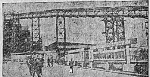
Донецкая область. На Идновском металлургическом заводе «Азовсталь» имени С. Орджоникидзе широко развернулось строительство крупнейшего в стране кислородно-конверторного цеха. Новый сталеплавильный гигант — это конверторы емкостью 350 тонн каждый, кислородный блок большой мощности и установка непрерывной разливки стали. В технологии производства найдут применение современные методы автоматического контроля за ходом плавки и разлива
