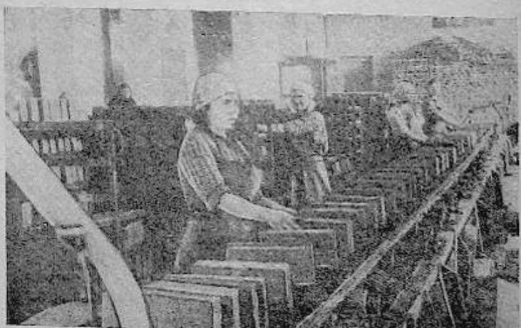
Беспрерывным потоком движется по конвейерной ленте кирпич-полупрофабрикат, поступающий из автоматического пресса. Этот сырец складывается на тележки и после искусственной сушки загружается в топильные газогенераторные печи для обжига.
