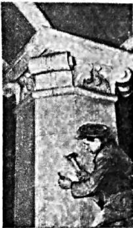
Строительство 4-й очереди Московского метрополитена. Рабочник А. Захаров из отдела колоний на станции «Комсомольская».
