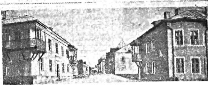
С каждым годом расширяется Касментьевский поселок. Мы видим на снимке многоквартирные дома. Только в прошлом году пять таких домов были заселены жителями. В наступившем году жилищный отдел предполагает выстроить 3 новых домов с площадью в 2780 квадратных метров.
